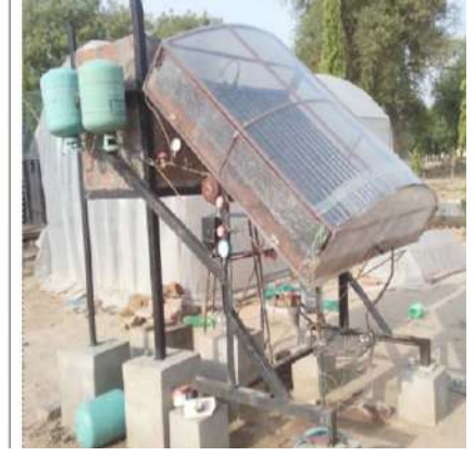
चित्र 2: उष्ण एवं शुष्क क्षेत्रों हेतु सौर अवशोषण शीतलन संचालित खेत-स्तरीय कोल्ड स्टोर
