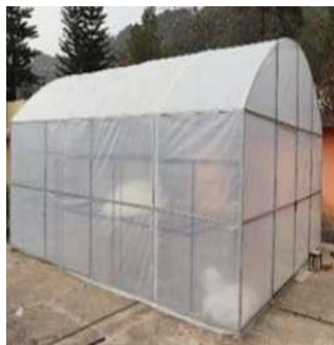
चित्र 3: अधिक वर्षा वाले क्षेत्रों के लिए उपयुक्त स्वचालित सौर सुरंग आधारित सुखाने की प्रणाली
