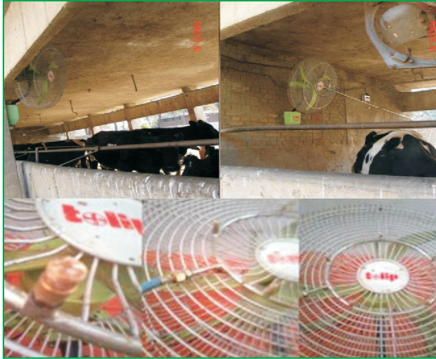
Fig. 24 .Fogger and fan system
